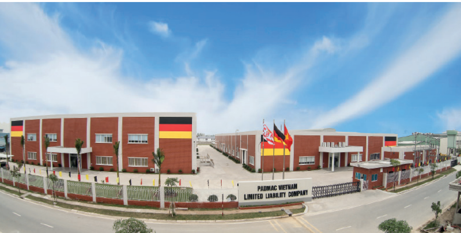
Fabrikhalle der PADMAC VIETNAM im nördlichen Nam Dinh
